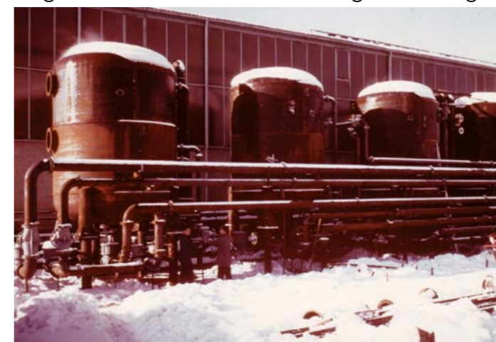
Behälter für Togliattigrad, Werkshalle Holzgerlingen
